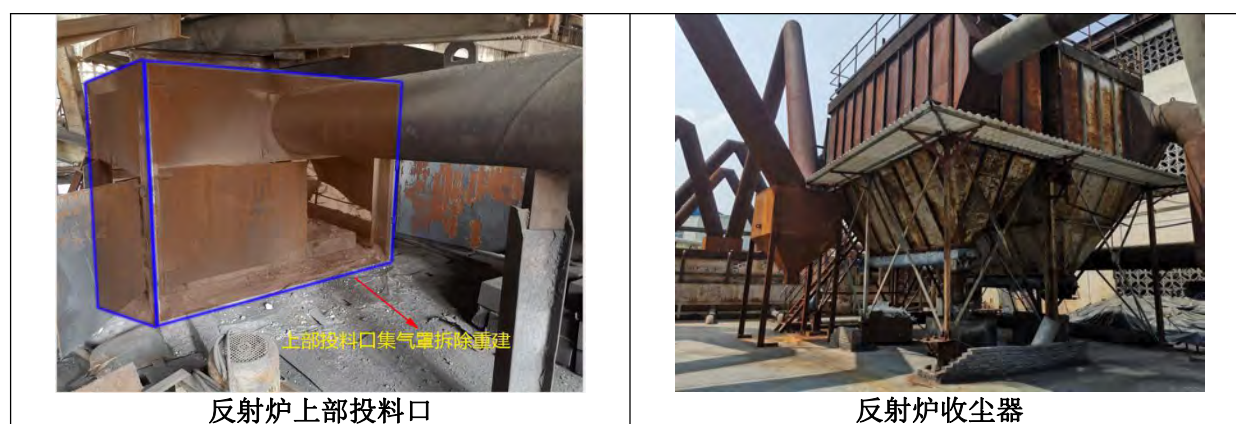
图 5.2-8 铜浮渣车间无组织排放控制措施
