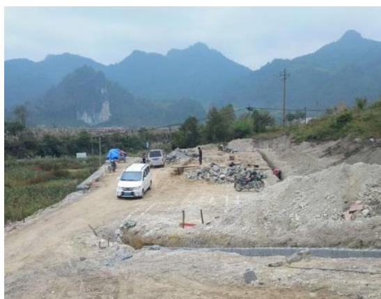
背基 1 安置点现状
