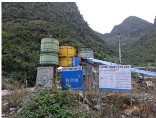
混凝土拌和系统现状
