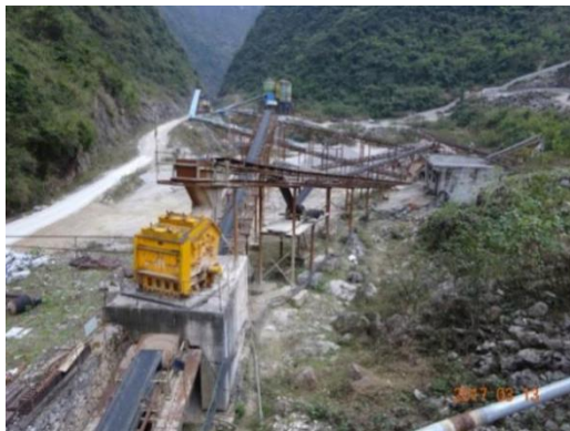
砂石料加工系统现状
