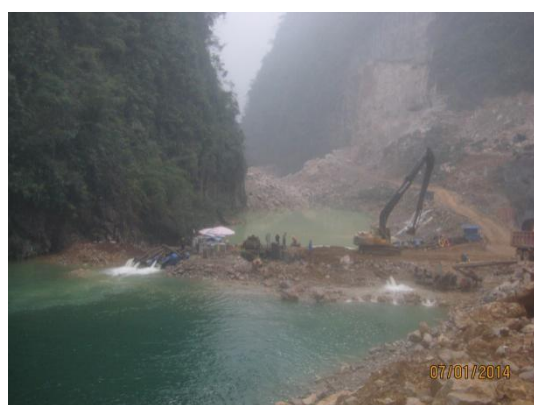
下游围堰现场
