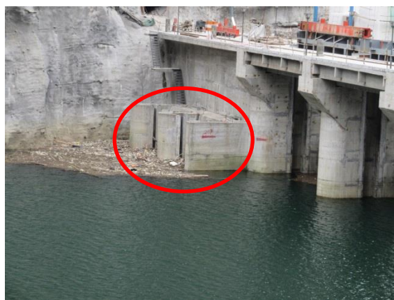
水电站进水口
