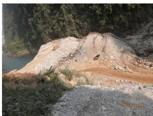
上游围堰现场
