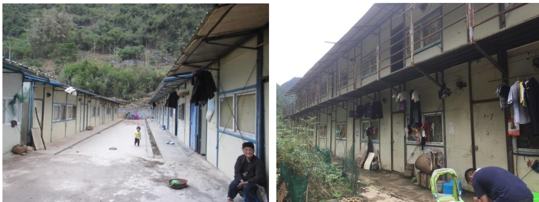
电站施工营地临时过渡安置区
