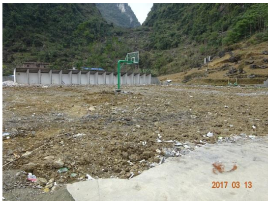
施工营地平整现状
