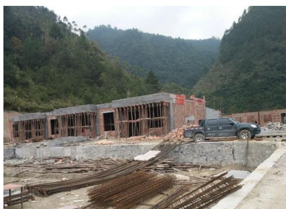
背基 2 安置点现状
